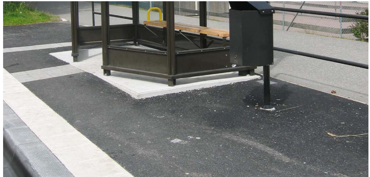
Busshållplatser med plattformsbeläggning av asfalt kontrastmarkeras. Effekten avtar även här allteftersom asfalten ljusnar. Bilden kommer från Rappedalens busshållplats.
