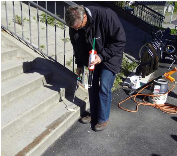
Ovanstående bild visar applicering av tätskikt "tvåkomponents primer". I bilden nedan värms markeringen fast på trappsteget.
