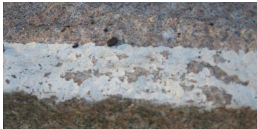
Bilden ovan visar en detalj från en målad markering på natursten som suttit på plats i ett år.
