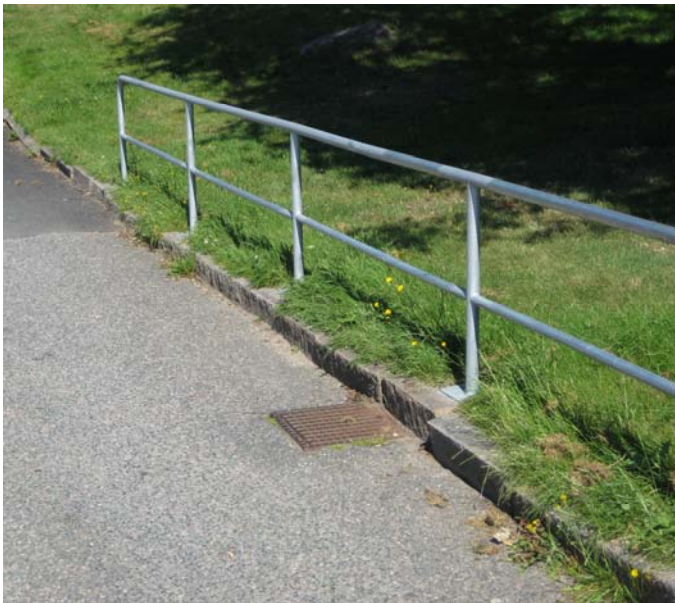
Helsvetsat räcke fritt från vegetation. Räcket har en lämplig placering i förhållande till kantstöd och snöröjning kan ske fritt från hinder. Bilder ovan och nedan från Högsbogatan
