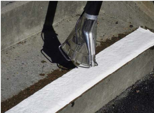
Ovanstående bild visar applicering av tätskikt "tvåkomponents primer". I bilden nedan värms markeringen fast på trappsteget.
