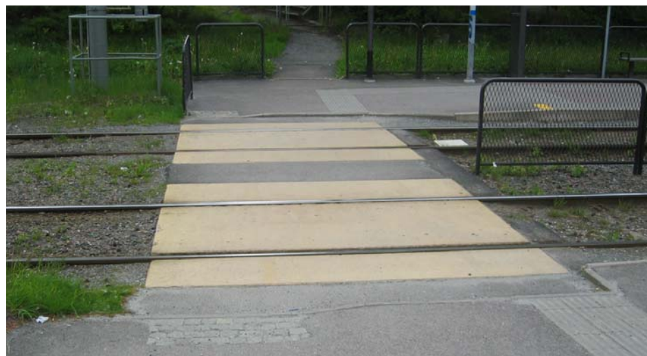
På spårvagnshållplatsen Januarigatan har befintlig sänkning enligt tidigare standard lämnats utan åtgärd. På sikt kommer alla spårpassager att byggas om för ökad trafiksäkerhetsstandard. Nyttan bedöms därför större att använda tilldelade budgetmedel för åtgärd där anpassningar saknas.
