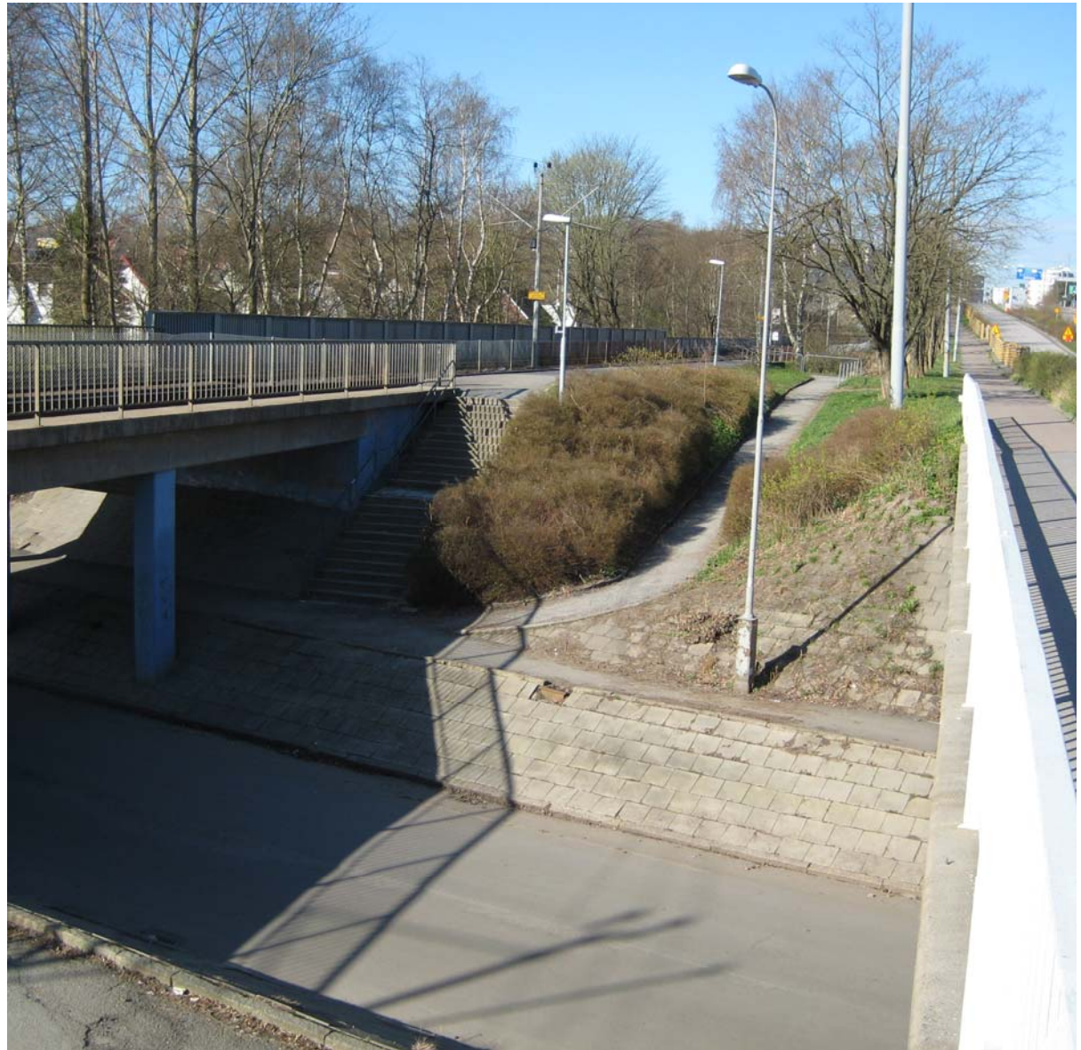
Helsvetsat räcke fritt från vegetation. Räcket har en lämplig placering i förhållande till kantstöd och snöröjning kan ske fritt från hinder. Bilder ovan och nedan från Högsbogatan
