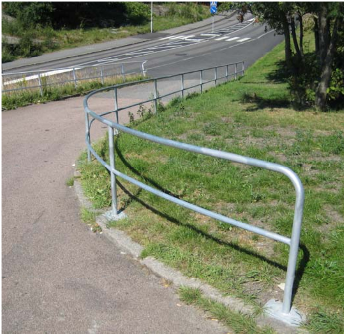
Helsvetsat räcke fritt från vegetation. Räcket har en lämplig placering i förhållande till kantstöd och snöröjning kan ske fritt från hinder. Bilder ovan och nedan från Högsbogatan
