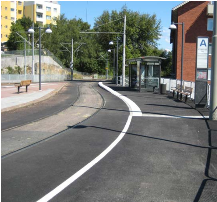
Spårvagnshållplatsen på Axel Dahlströms torg (bilden ovan och nedan) har byggts om och kontrastmarkerats. Gul markering används för varning och vit markering för att upplysa om hinder, nivåskillnader eller andra detaljer i närmiljön.
