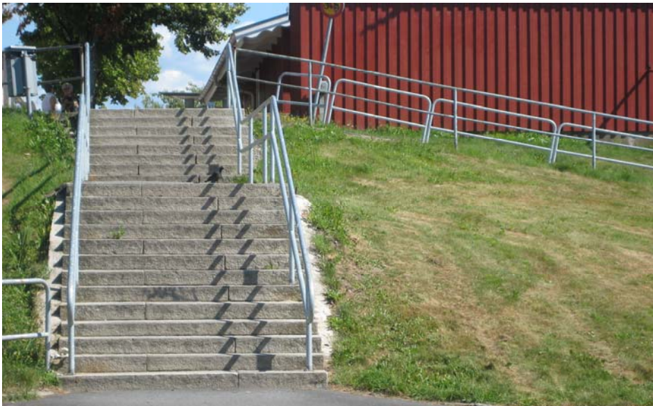
Vid Selma Lagerlöfs torg kompletterades det befintliga räcket med ett bågräcke i samma stil (se bild ovan). Från ett annat perspektiv smälter inte åtgärden inte alls in i omgivningen (bild nedan).
