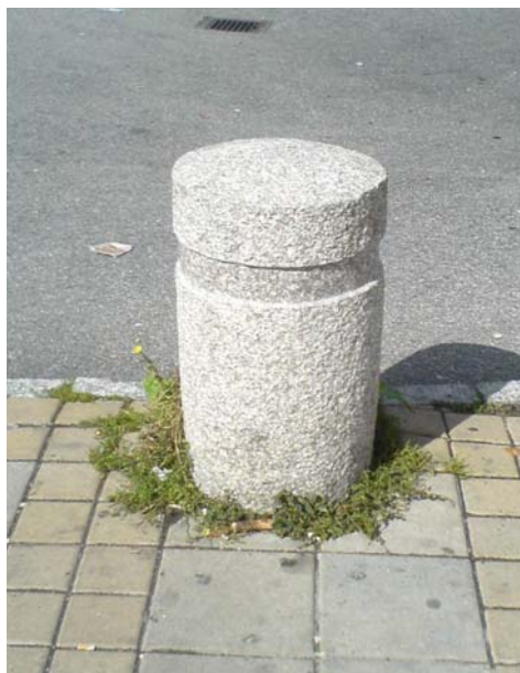
Bilderna visar två pollare på Selma Lagerlöfs torg där den vänstra markerats med färg i efterhand och den högra är av ljus granit som när anläggningen var ny kontrasterade mot den omgivande markbeläggningen som ljusnat med åren. Reflexmarkering saknas.
