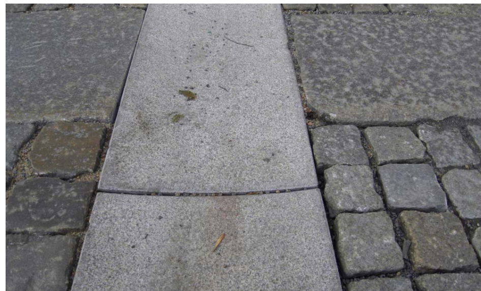
Inom Vallgraven byts djupa rännalar ut mot nytillverkad rännal i krysshamrad bohusgranit med svag skålning över hela stenens bredd.
