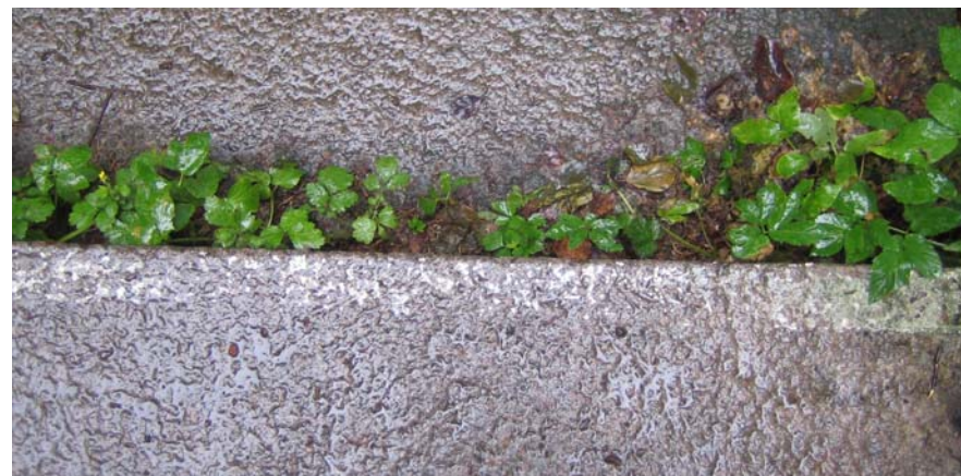
Erfarenheter visar att kontrastmarkering på trappor i natursten har begränsad hållbarhet på grund av stenens egenskaper och ofta ojämna yta. Färg har svårt att få fäste och linjemassan måste vara så elastisk att den griper tag så att inget utrymme lämnas öppet under markeringen. Kommer fukt in under markeringen fryser den och frostspränger det applicerade materialet. Bilden ovan visar en markering målad på granittrappa med epoxibaserad färg efter 3 år.
