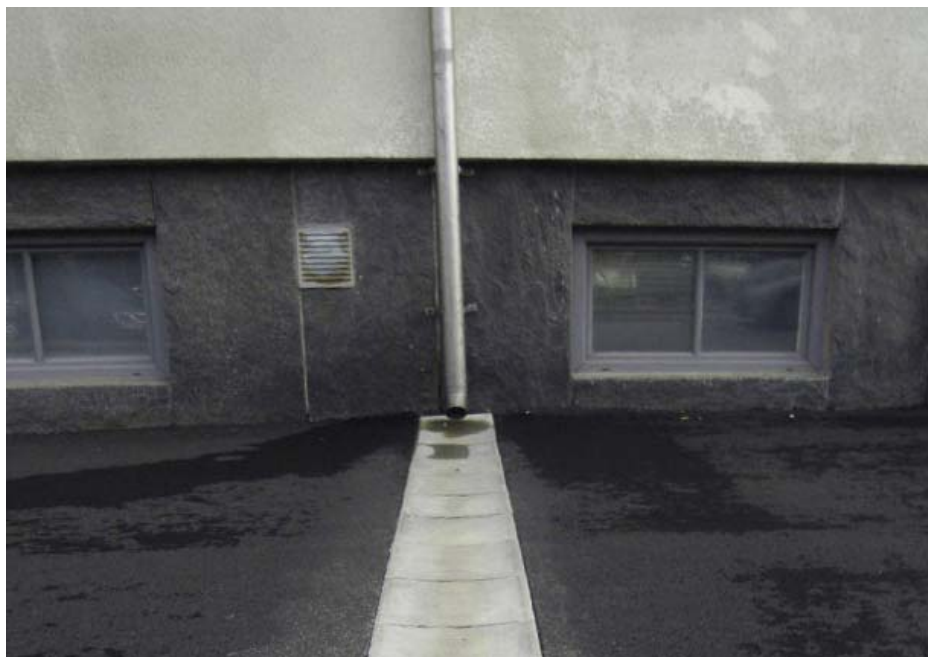
Rännalsplatta i betong med svag skålning används vid byte av rännalar med asfalt i gångbanan och kantstöd av råkant eller betong. Bilden ovan är tagen på Gibraltargatan.
