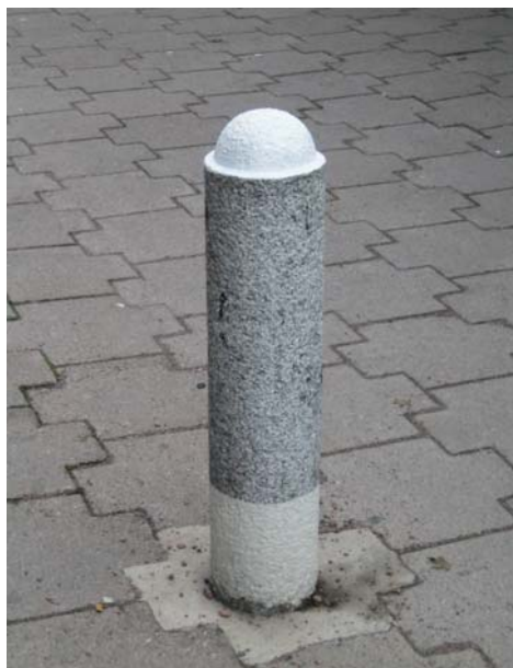
Bilderna visar två pollare på Selma Lagerlöfs torg där den vänstra markerats med färg i efterhand och den högra är av ljus granit som när anläggningen var ny kontrasterade mot den omgivande markbeläggningen som ljusnat med åren. Reflexmarkering saknas.
