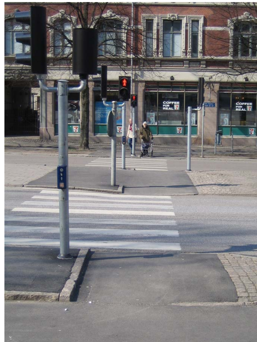
Det signalreglerade övergångsstället på Övre Husargatan som visas i ovanstående bild har utförts enligt senaste revideringen av Trafikkontorets projekterings- och utförandeanvisningar, TPU. Här samsas synskadade och rörelsehindrade om samma tryckknapp utan att behöva sidoförflytta sig. Genom att samverka med underhållsarbeten kan arbetet effektiviseras.
