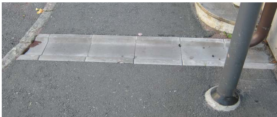
Bilden ovan visar en rännalsplatta ur leverantörens standardsortiment. Plattan används i vissa fall som rännal parallellt med gångbanan. Den har dock för skarpa avfasningar för att fungera optimalt tvärs gångbana och används därför inte som standard i Göteborg. På Herkulesgatan hade fel typ av platta lagts men är nu utbytt till den svagt skålade rännalsplattan som används som standard.
