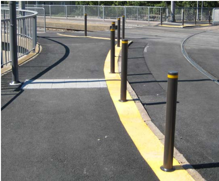
Spårvagnshållplatsen på Axel Dahlströms torg (bilden ovan och nedan) har byggts om och kontrastmarkerats. Gul markering används för varning och vit markering för att upplysa om hinder, nivåskillnader eller andra detaljer i närmiljön.
