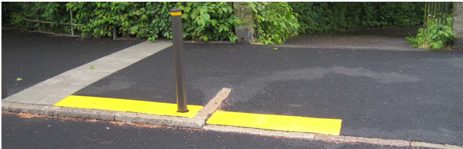
Bilden ovan från Ekmanska visar gällande standard för utförande av gångpassager över spår med kontrastmarkering av kant, pollare och ramp.
