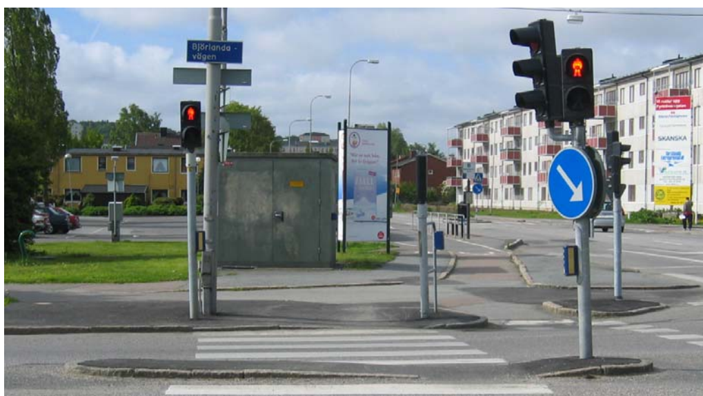
På Björlandavägen har kantstödssänkningar utförts utan att signalstolpar flyttats vilket ger omvägar för att nå tryckknapp och en svårorienterad miljö för den synskadade.
