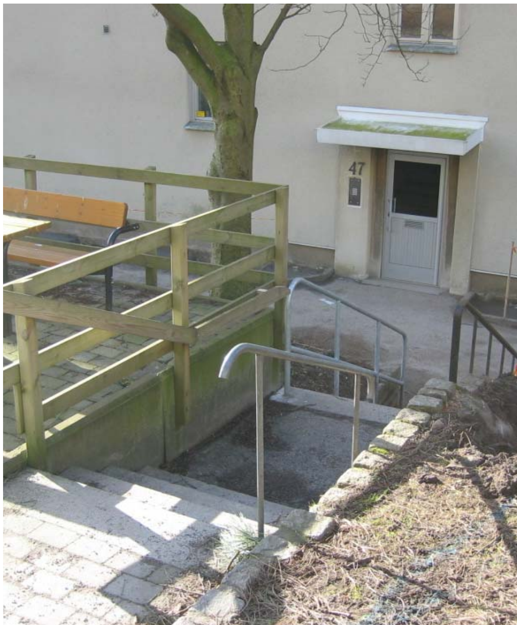
Bilden ovan från en bostadsgård i Älvsborg visar ett avskräckande exempel ur estetiskt perspektiv där fyra typer av ledstång använts i samma trappa.
