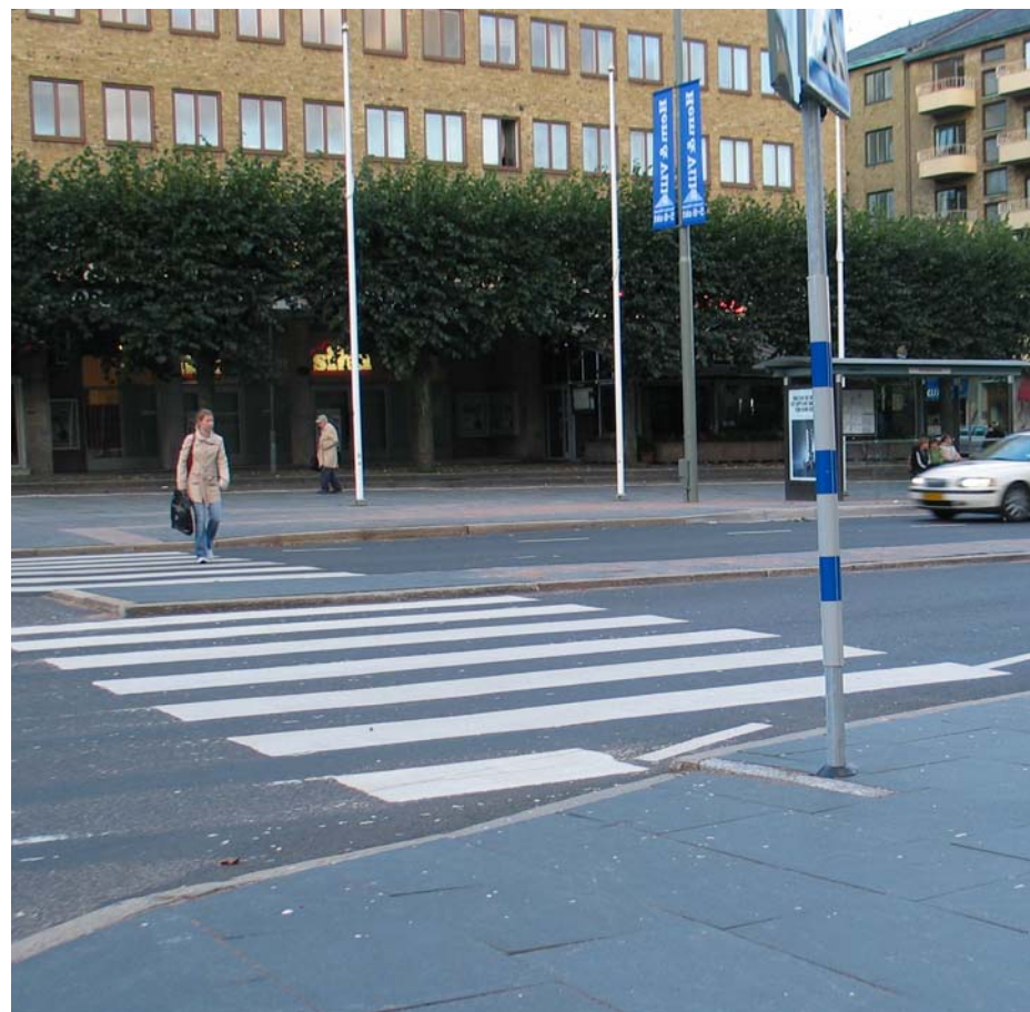
På skyltstolpen till övergångsstället vid Götaplatsen har reflexrör monterats istället för tapemarkering. Åtgärden ger ett permanent intryck men är för dyr att använda som standardåtgärd. Reflexrör finns endast tillgängligt för skyltstolpar av standarddimension.
