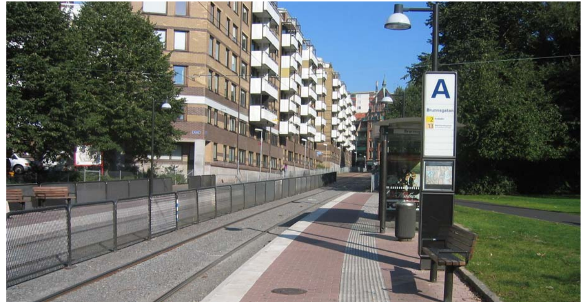
Hållplatsen vid Brunnsgatan byggdes om 2006. Den röda betongmarkstenen kontrasterar mot de genomfärgade vita betongplattorna närmast kanten. Effekten beror av väderförhållanden och avtar med tiden då markstenen bleknar.
