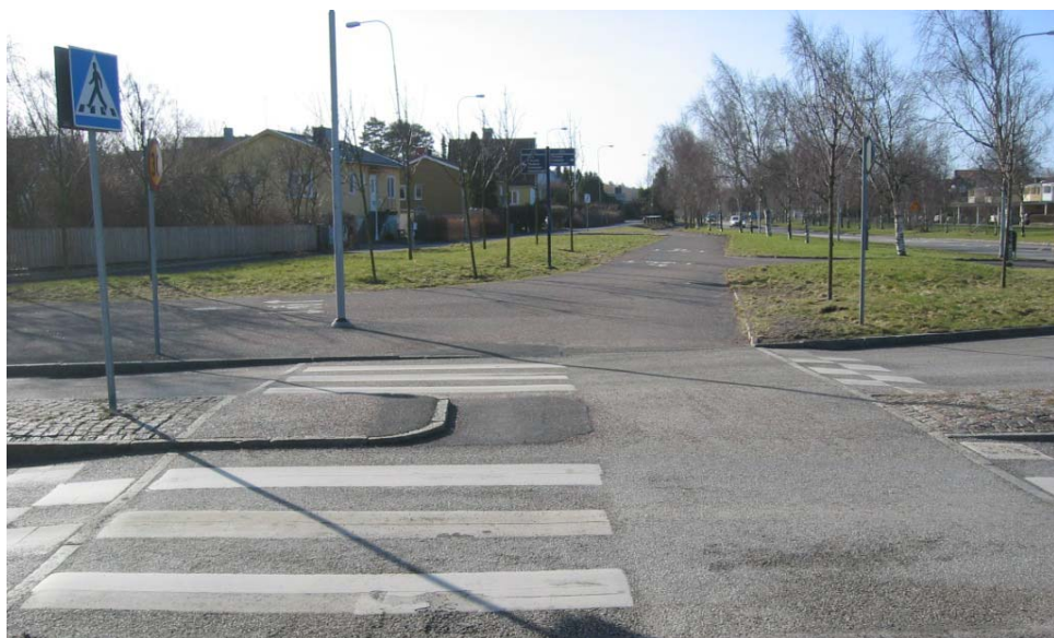
I vissa fall kan cykelbanan nyttjas som nollad gångpassage för rullstolsburna. Här har dock en separat ”rullstolsbana” anlagts eftersom cykelbanan är ett frekvent huvudstråk med höga farter.
